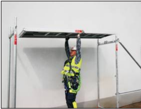
Montaż podestu komunikacyjnego
