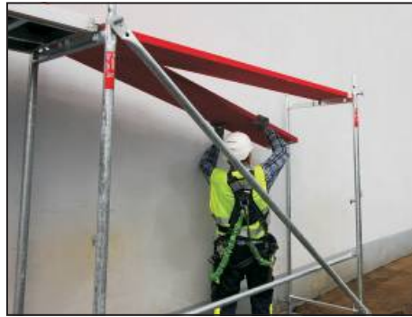
Montaż podestów roboczych
